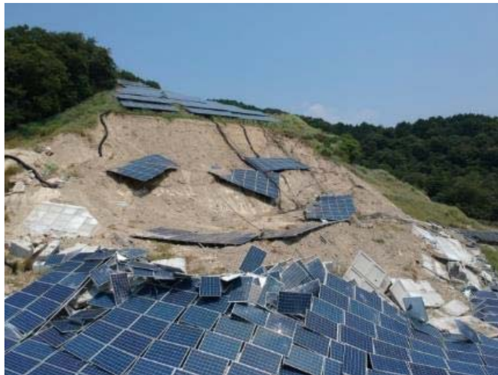
↑ 土砂崩れ被害
