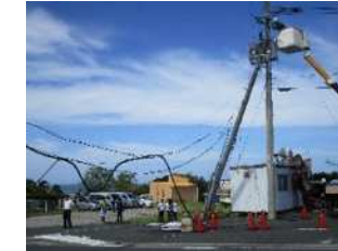
図1-10 構内柱（倒伏）
