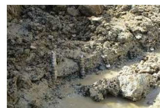
図1-5 鉄筋破断 （フーチング上面）
