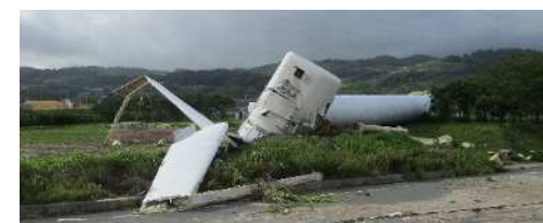
図1-8 ローターヘッドが地面に激突
