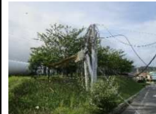
図1-9 構内柱（折損）
