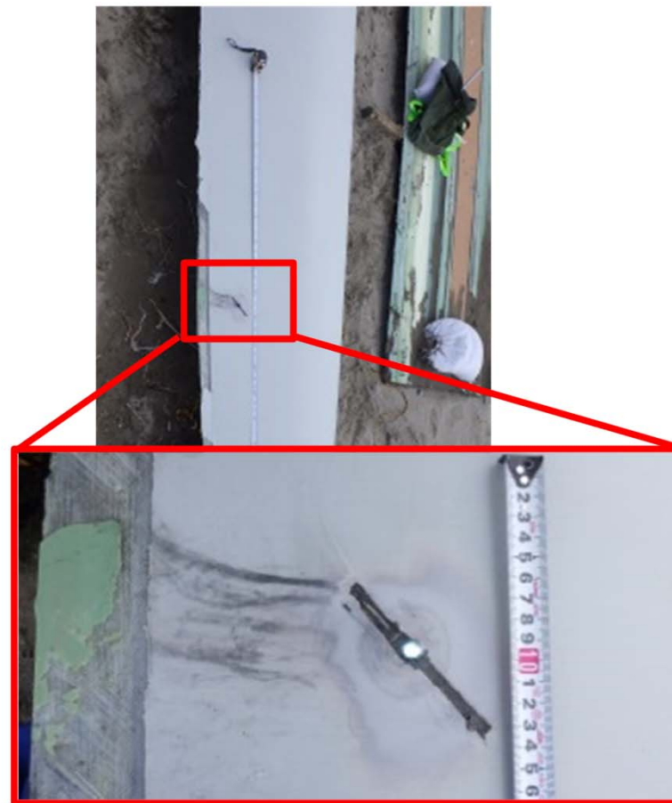
写真6 ブレード損傷箇所（地上での撮影）
