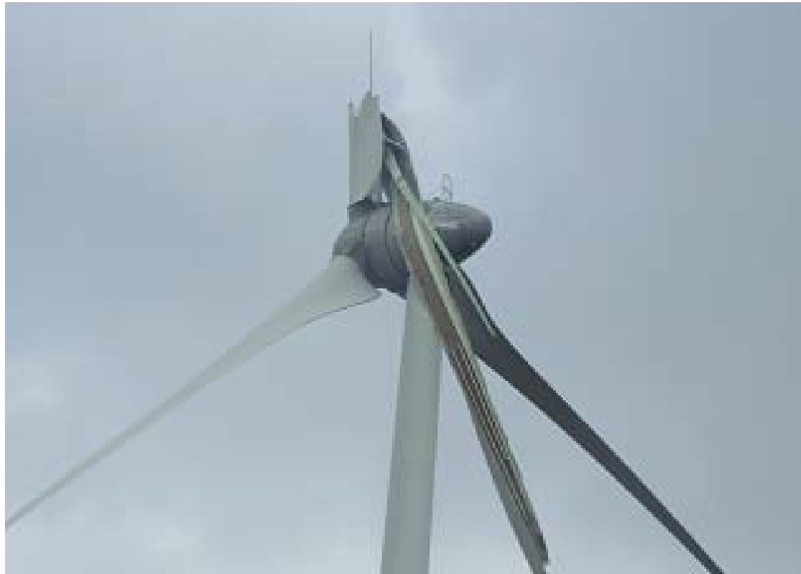
写真2 風車損傷状況
