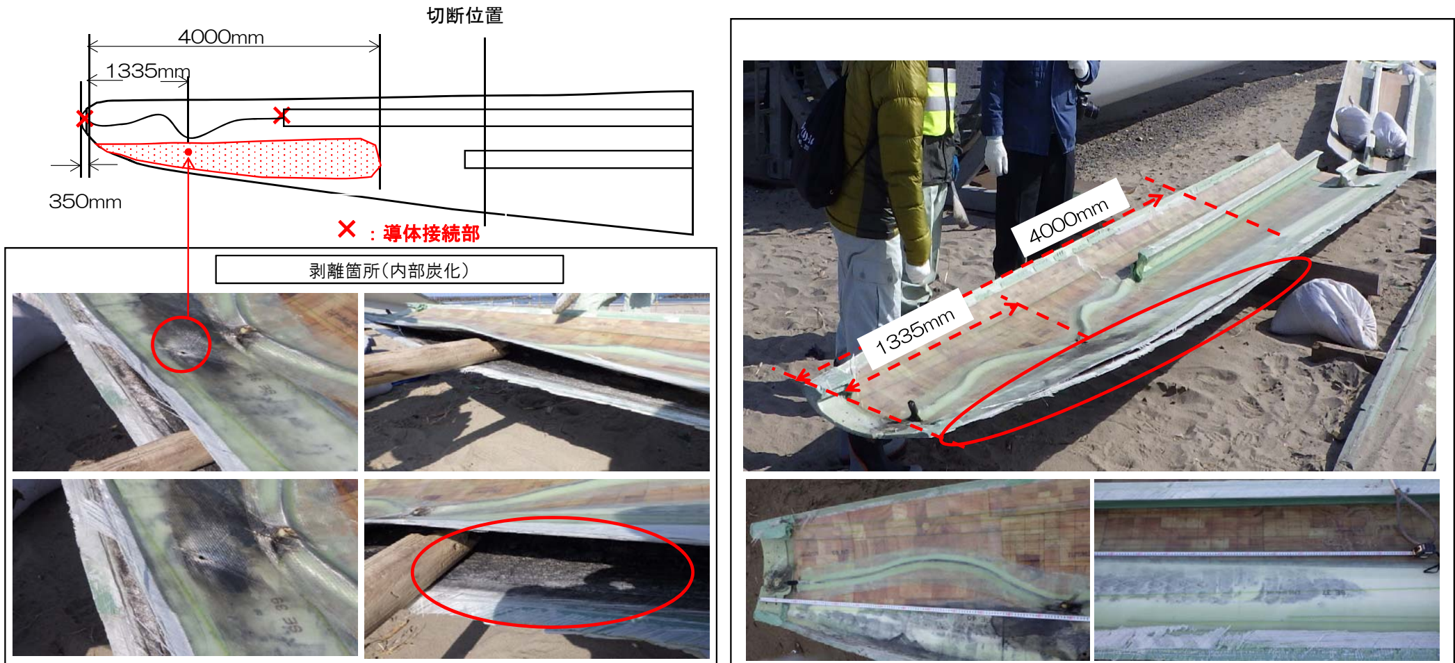
図8 ブレード内面損傷状況
