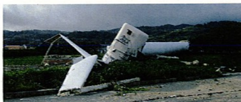
図1-8 ローターヘッドが地面に激突
