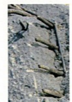
図1-4 基礎部 （ペDESTAL底面）
