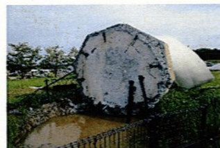
図1-4 基礎部 （ペDESTAL底面）
