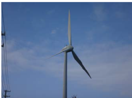
【写真3（2号機全体写真）】
