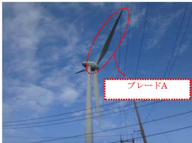
【写真1(1号機全体写真及びブレードAの状態)】
