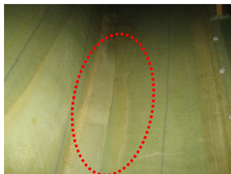
③ブレード根元部クラック (内側)
