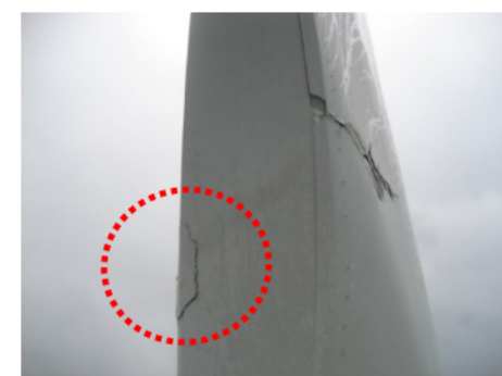
②ブレード根元部クラック (外側)
