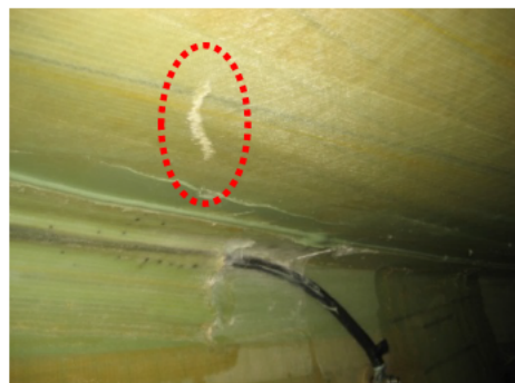
①ブレード内部クラック
