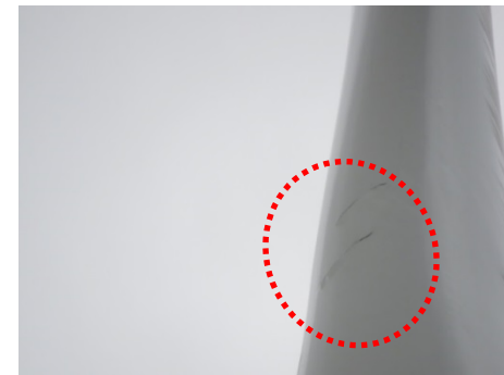
②ブレード根元部クラック (外側)
