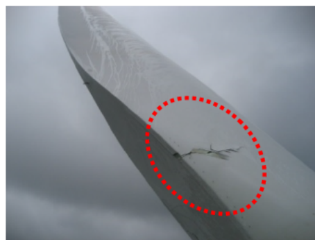
①ブレード根元部クラック (外側)
