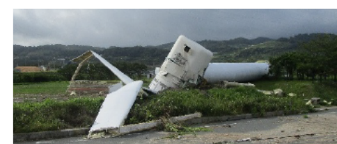
図1-8 ローターヘッドが地面に激突
