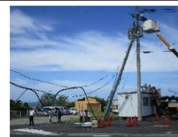
図1-10 構内柱（倒伏）
