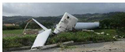
図1-8 ローターヘッドが地面に激突
