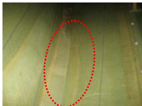
③ブレード根元部クラック (内側)
