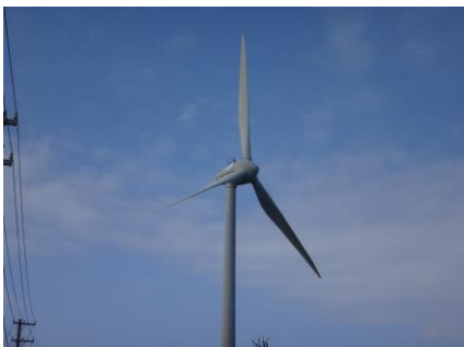
【写真3（2号機全体写真）】
