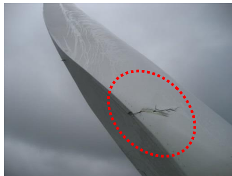
①ブレード根元部クラック (外側)
