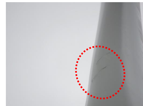
②ブレード根元部クラック (外側)
