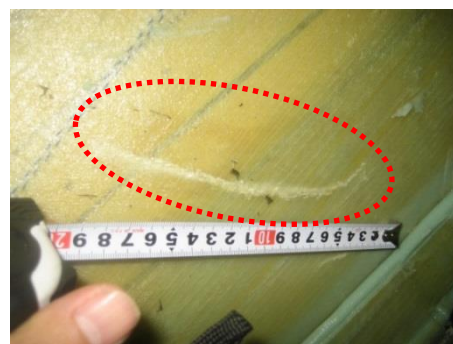
②ブレード内部クラック
