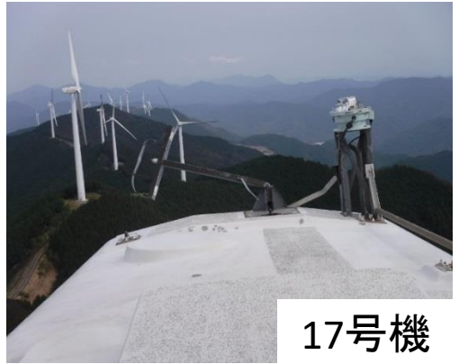
② 風向計の損傷状況
