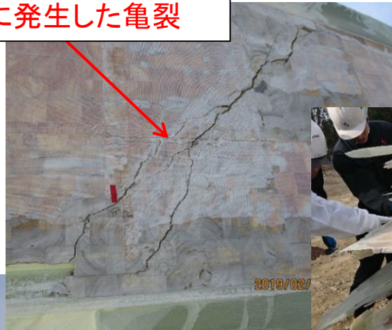
内部桁の破損状況
