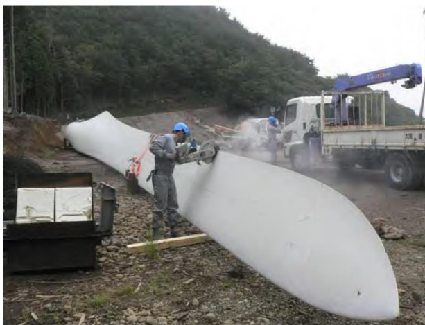
ブレード切断状況
