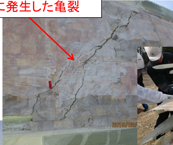
内部桁の破損状況
