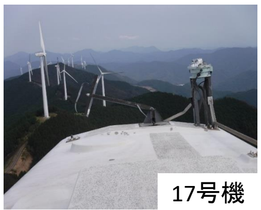
② 風向計の損傷状況
