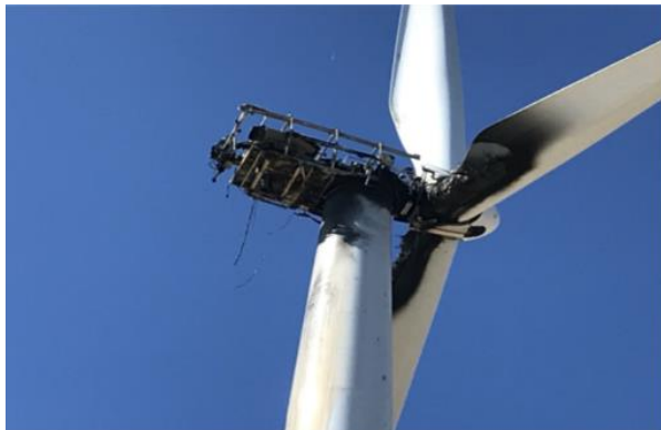
図1.3(1) 火災事故(消火後)
