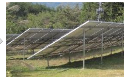
野立ての太陽電池発電設備
