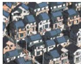
住宅用太陽電池発電設備
