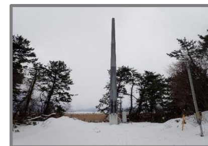
小出力発電設備(風力)の事故 (ナセルの落下、本年1月)
