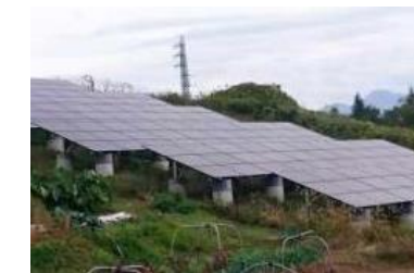
架台に使用済みドラム缶を使用
