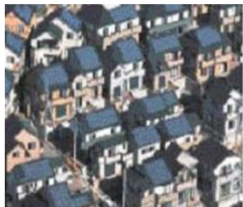
屋根への設置
