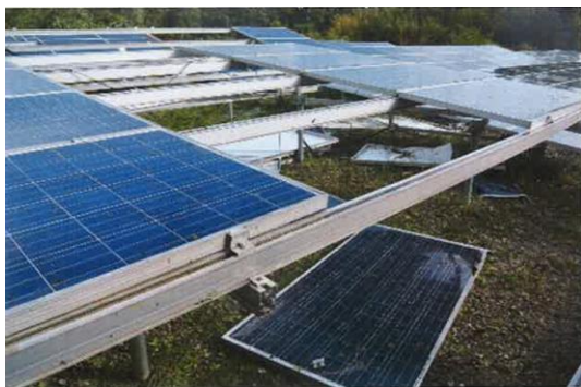
台風の強風によりパネルが飛散
