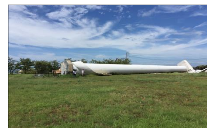
風力発電設備崩壊事故（2018年8月、淡路市）
