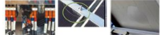
参考：平成27年度エネルギー庁・導入促進推進課(再生・可能エネルギーの長期安定供給に向けた制度構築) 発電機 IIA-PVPS T13-01 2014 Review of Failures of Photovoltaic Module Final
