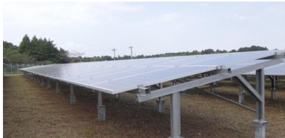
10～50kW未満非住宅太陽光システム （地上設置の例）
