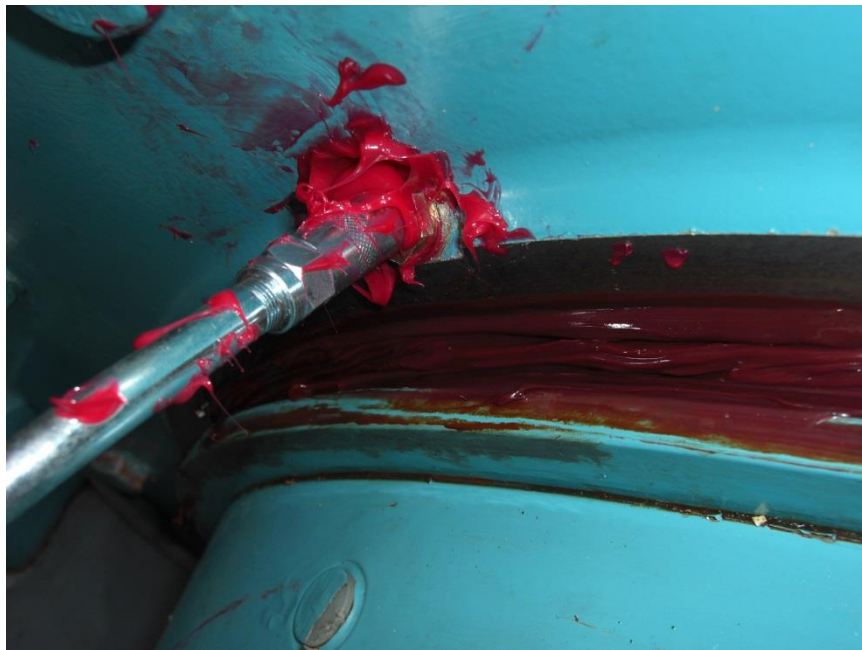
図6.4 1号機グリス注入時の状態 (モービルSHC460WT)
