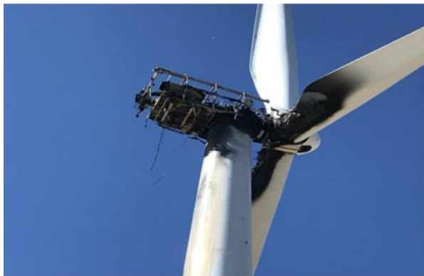
図1.3 (1) 火災事故(消火後)
