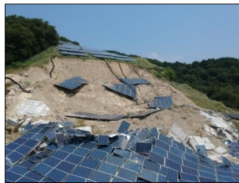
太陽光パネル崩壊事故（2018年7月、姫路市）
