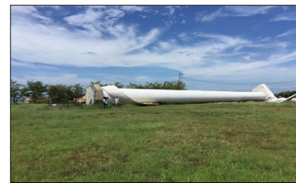
風力発電設備倒壊事故（2018年8月、淡路市）
