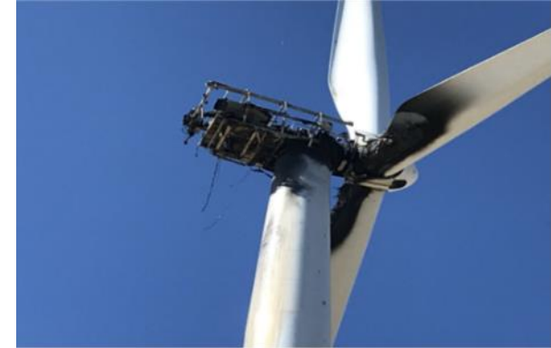
図 1.5 火災事故(消火後)
