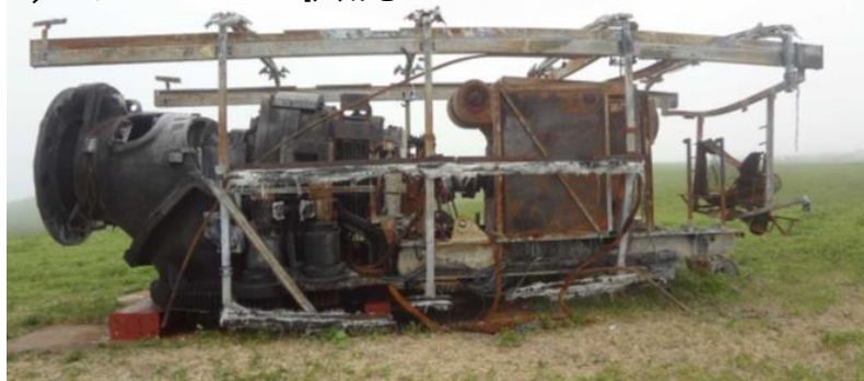
別添 2.4 ナセル損傷状況
