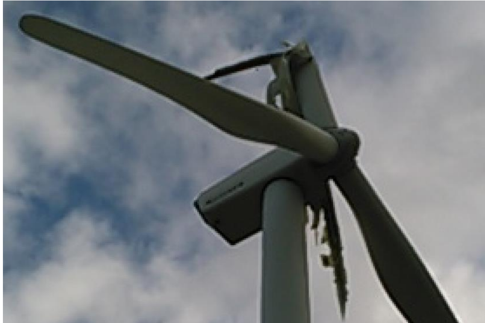
ブレードが折損した事故機
