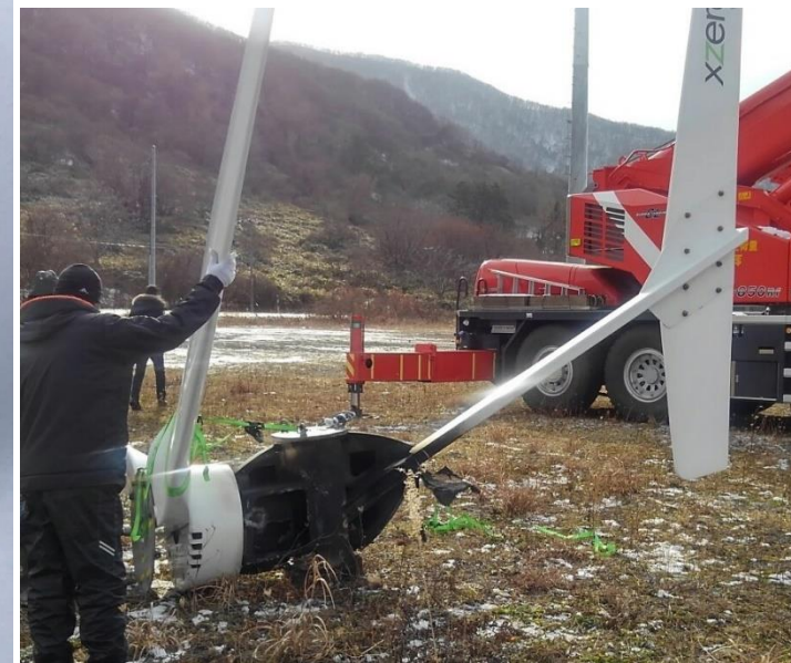
タワーから撤去した事故機
