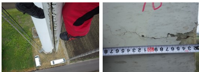
図3-2 直近のブレード点検結果写真
