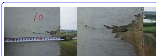
31m近傍コード方向クラック (2019.5.31点検時10番位置)
