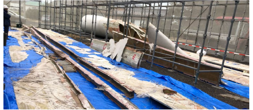
図4-2 破損ブレード集積場内部（写真）
