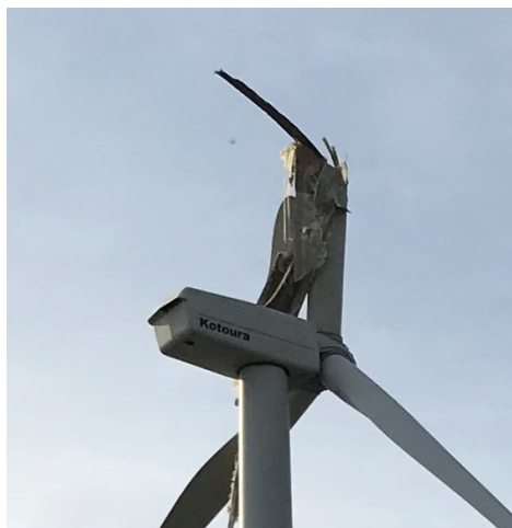
図1-5 折損した風車の状況
