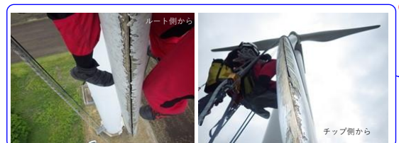
先端付近開口 (2019.5.31点検時31m~Tip間約2.5m範囲)
