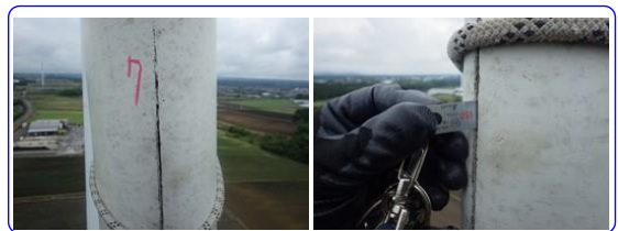
23m近傍スパン方向クラック (2019.5.31点検時7番位置)
