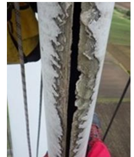
【経年変化③】 損傷進展・開口拡大 (2019年東伯4号#1ブレード)
