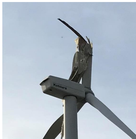
図2-1 折損した風車の状況
