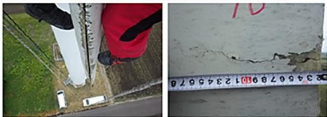
7. 31m~Tip部 開口、繊維損傷
