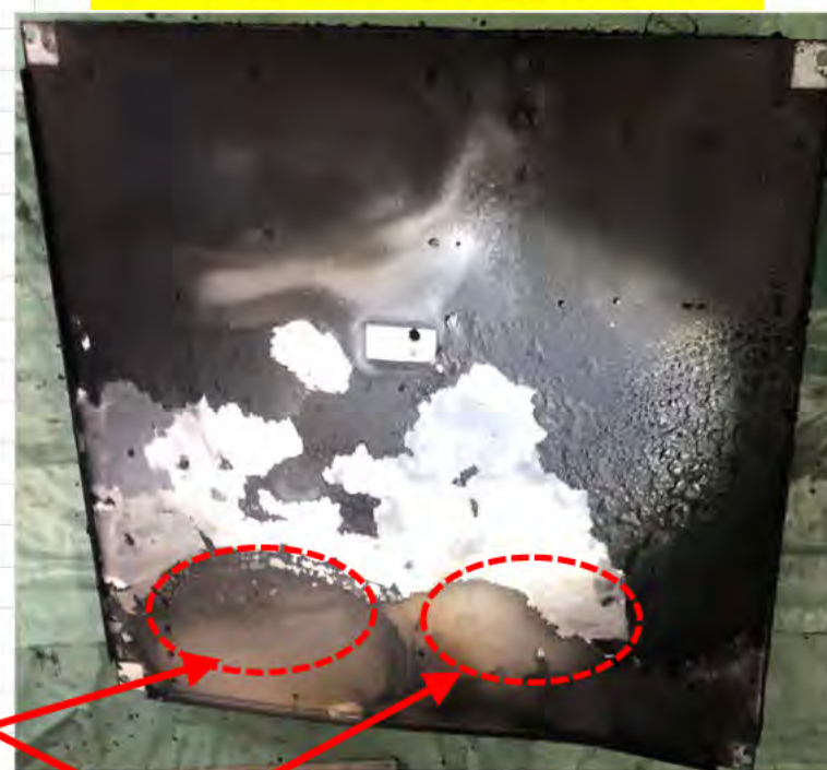
24V、27V電源 入力端子部
