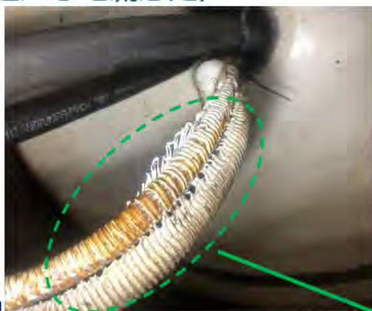
ケーブル仕様 BIHFP-J 5C4mm 2 シリコン系鋼保護付き耐熱型
