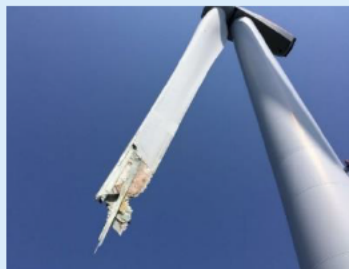
ブレード破損状況
