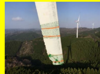
落下防止養生 (4月20日実施)
