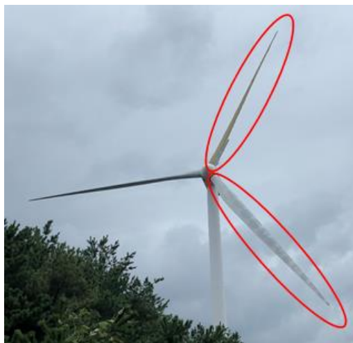
16号風車:ブレード2枚破損
