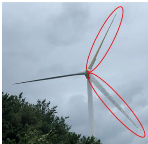
16号風車:ブレード2枚破損
