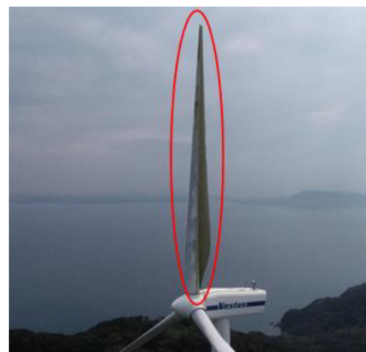
7号風車:ブレード1枚破損
