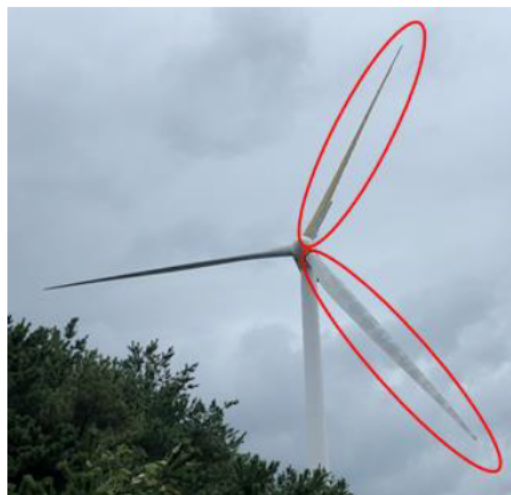
16号風車:ブレード2枚破損
