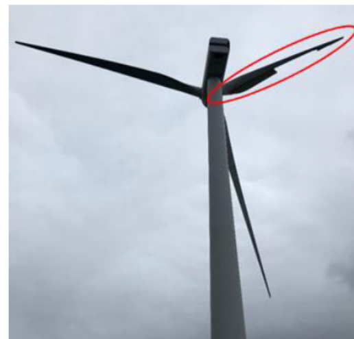
13号風車:ブレード1枚破損
