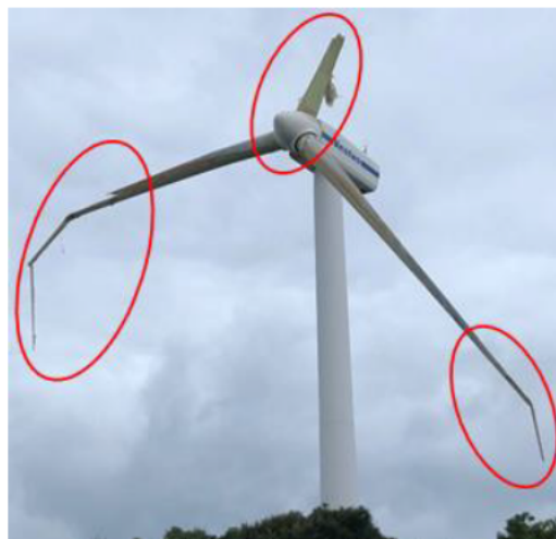
8号風車:ブレード3枚破損
