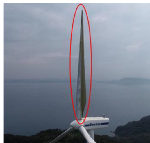
7号風車:ブレード1枚破損
