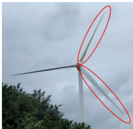
16号風車:ブレード2枚破損
