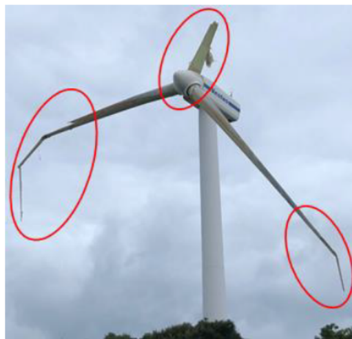
8号風車:ブレード3枚破損
