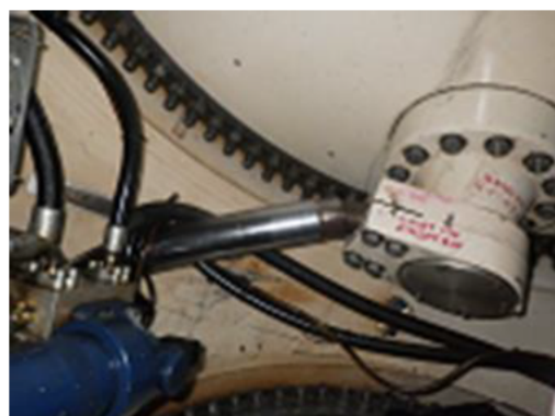
接続部が折れたシリンダシャフト
