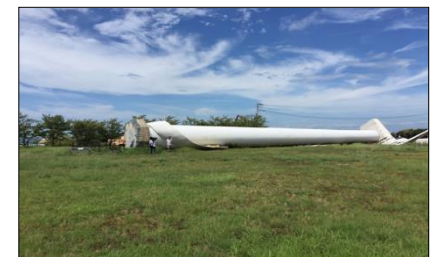
風力発電設備倒壊事故 (2018年8月、淡路市) 4
