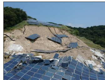
太陽光パネル崩壊事故 (2018年7月、姫路市)
