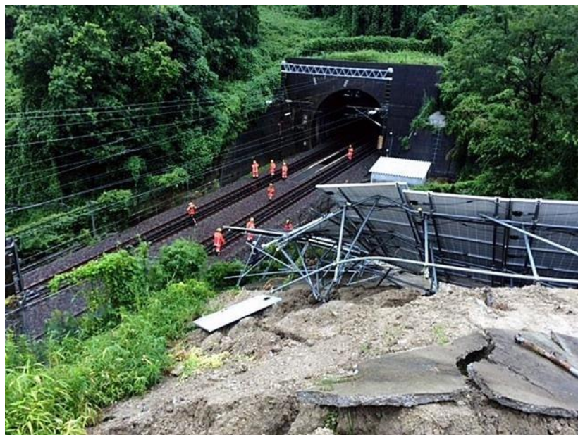
<小出力太陽電池発電設備の事故事例>
