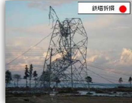
津波により折損した鉄塔
