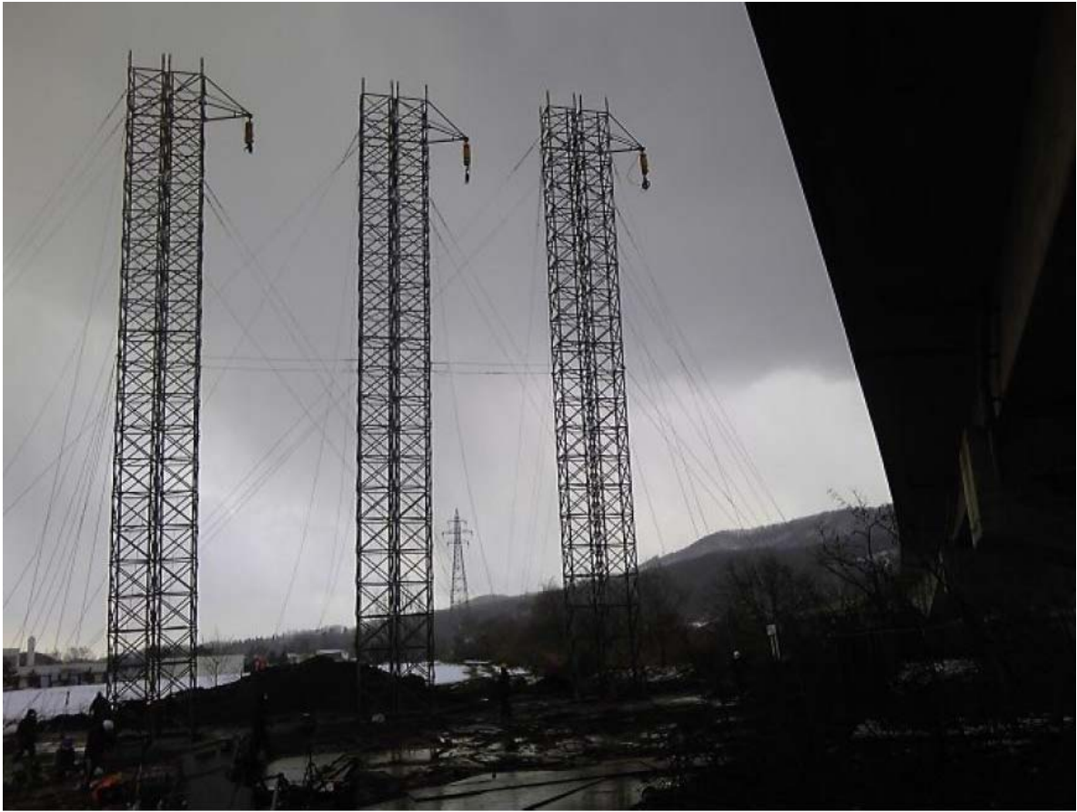
【写真3】仮鉄塔※29日8時時点
