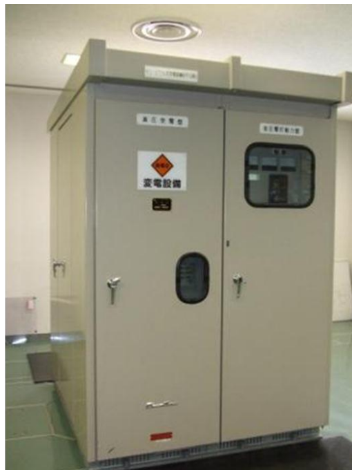
図3: 需要設備の受変電設備
