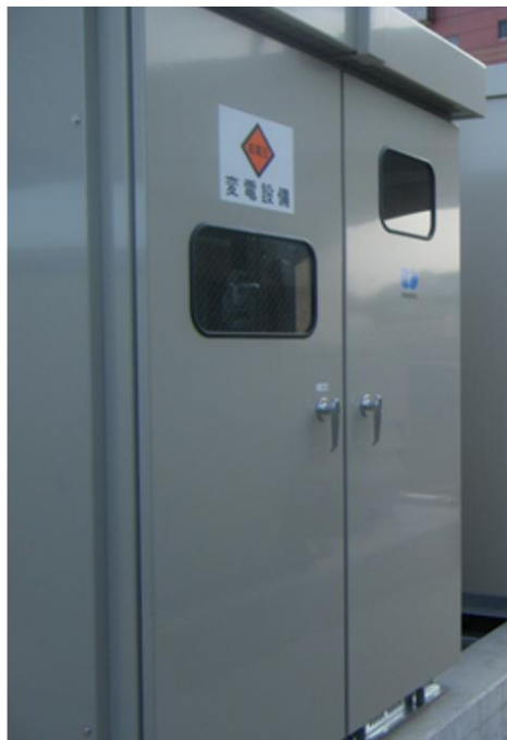
図2: 太陽電池発電設備の受変電設備
