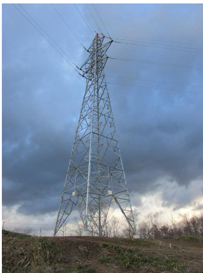
<建て替えられた倒壊鉄塔>
