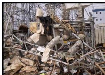
地上機器（ケーブルヘッド架台）の倒壊状況（宮城県多賀城市）
