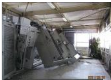
(写真3)制御盤の被害
