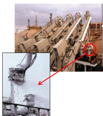
【離脱後】 燃料受入設備 緊急離脱装置 (LNGの例)
