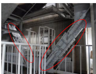
ボイラ支持架構の補強例
