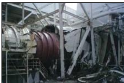
(写真2)通風機の被害
