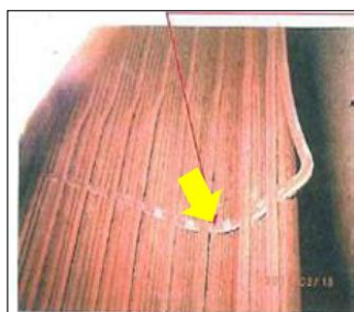
(写真2)クーリングスパーサー管の変形
