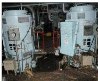
(写真1)復水ポンプ(電動機)の被害
