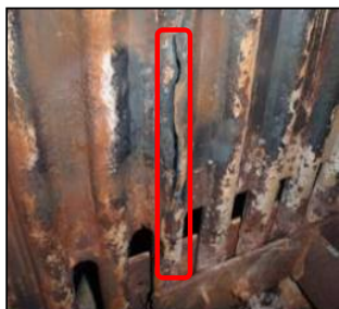
(写真1)ボイラーチューブの破孔
