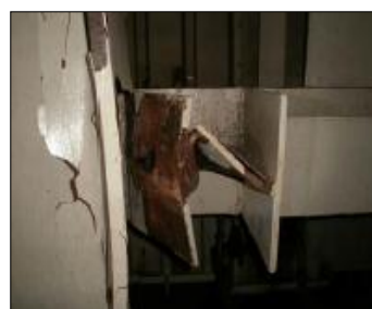
(写真3)ボイラー鉄骨の変形
