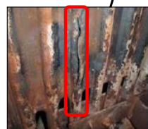
ボイラーチューブ の修理箇所
