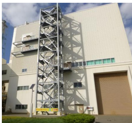
屋上への避難階段
