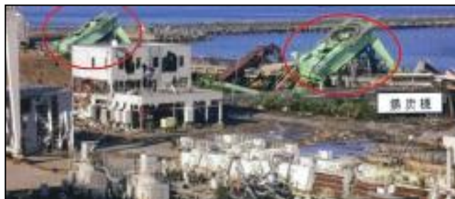
(写真4)揚炭設備の被害
