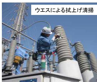
<降灰除去作業の例>
