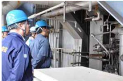
九州電力 荻田発電所
