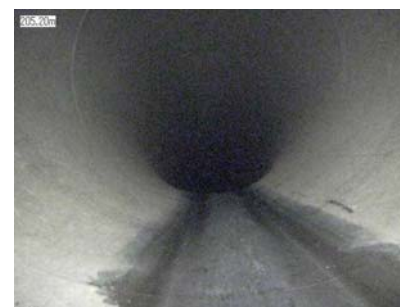
鉄管内画像 (全景)
