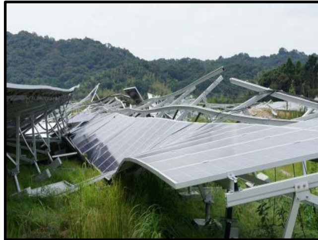
【本年8月：九州 台風15号被害】 （設備出力1,990kW）
