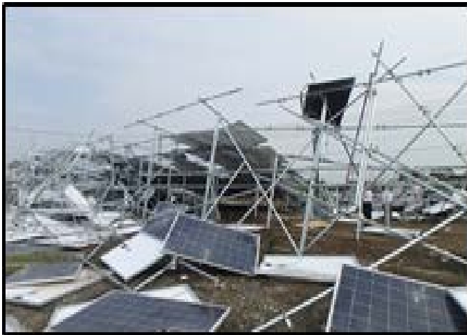
【本年6月：群馬県 突風被害】 （設備出力400kW）
