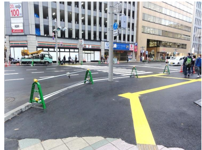
陥没箇所埋め戻し完了後の状況
