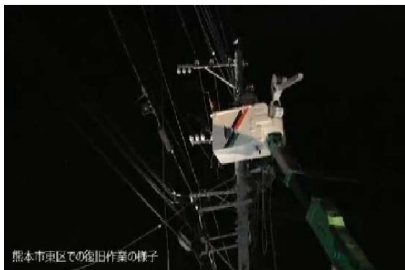
配電設備の復旧作業の様子
