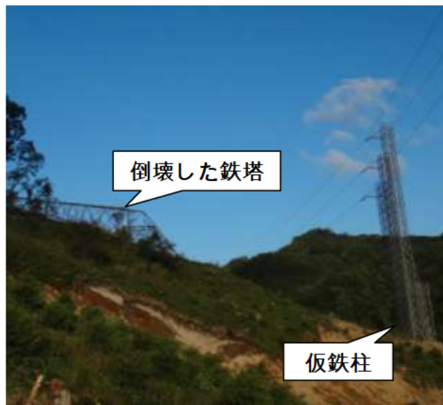
66kV岩知志線 鉄塔応急復旧状況
