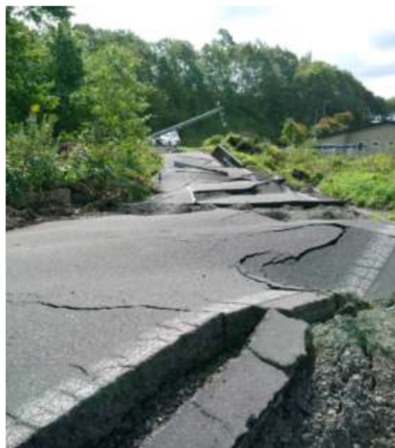
土砂崩れによる電柱傾斜 (勇払郡厚真町)
