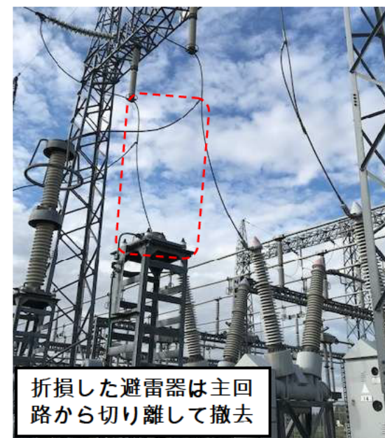
恵庭変電所 避雷器復旧状況
