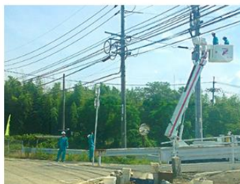
配電線の絶縁状態を測定する様子（広島県三原市内）
