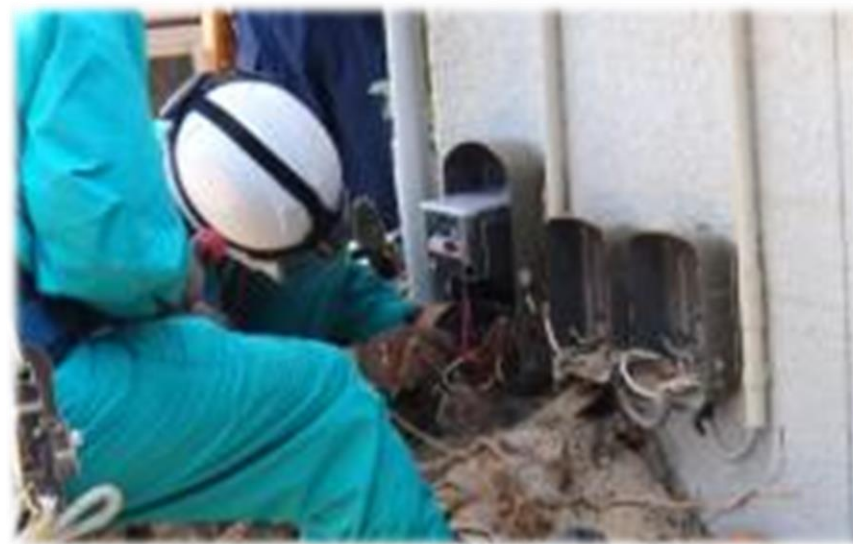
被災した家屋の漏電を調査する様子
