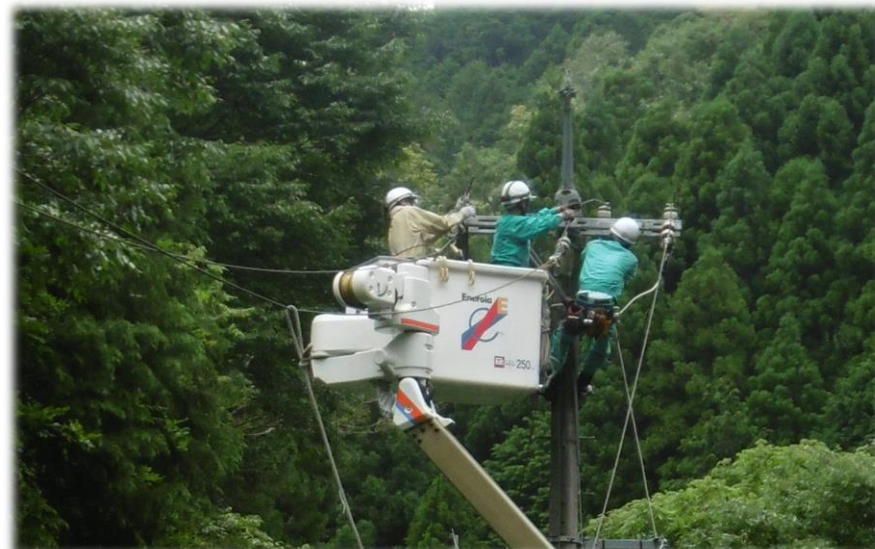
断線した高圧線を接続する様子
