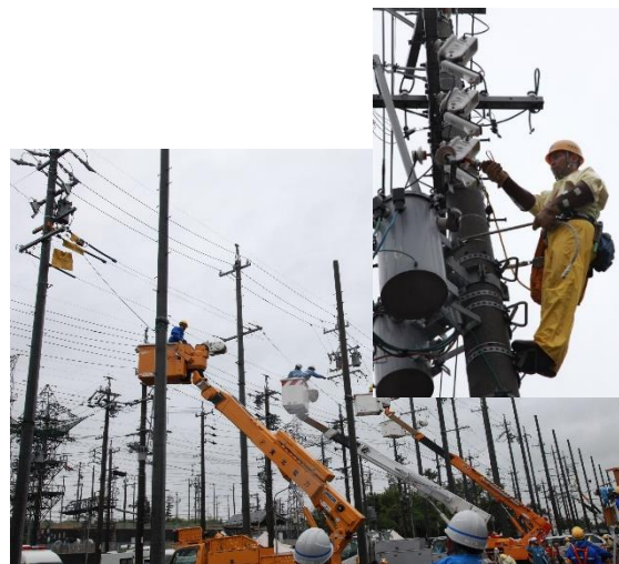
設備復旧訓練 (上：沖縄電力，下：全体)
