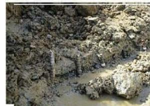
図1-5 鉄筋破断（フーチング上面）
