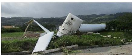
図1-8 ローターヘッドが地面に激突
