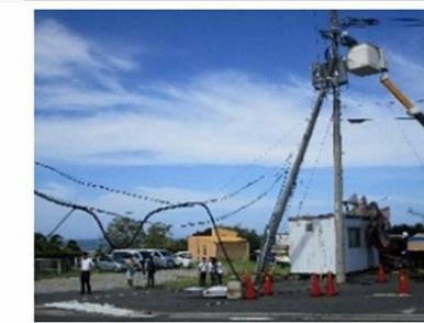
図1-10 構内柱②（倒伏）
