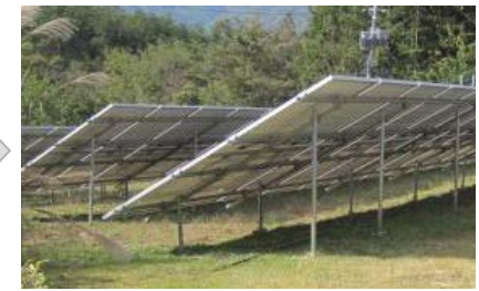
野立ての太陽電池発電設備
