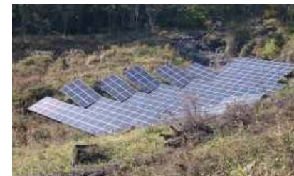
砂防指定地域内に設置されたパネル
