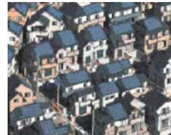
住宅用太陽電池発電設備
