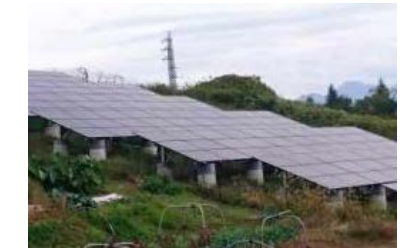
架台に使用済みドラム缶を使用
