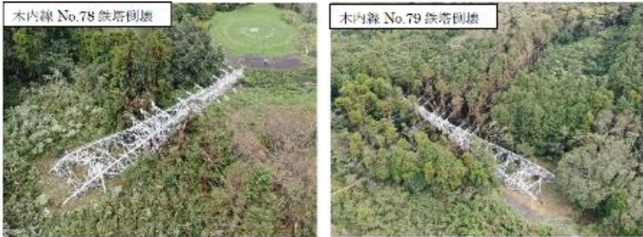
倒壊した鉄塔の様子（木内線No.78,79）
