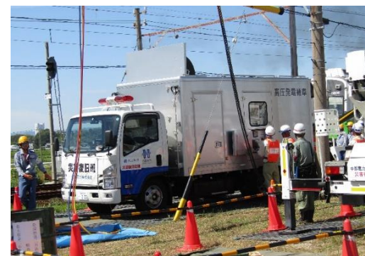
応急送電打合せ（北陸電力）
