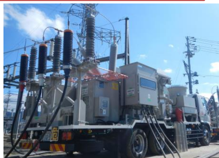
水没した変電所（長野県千曲市） 移動用変圧器による復旧（長野市）
