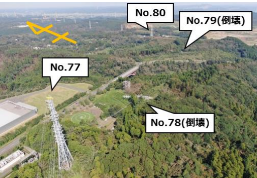
倒壊現場の様子
