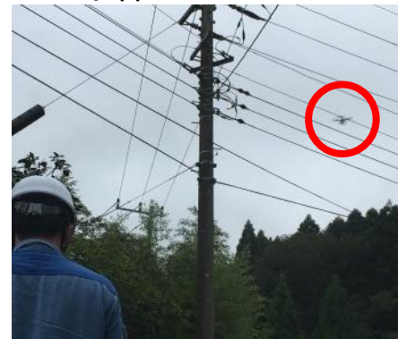
ドローン活用による 設備被害確認 (東京電力PG)
