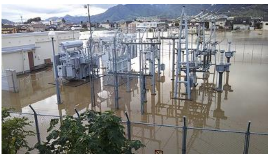
水没した変電所（長野県千曲市） 移動用変圧器による復旧（長野市）
