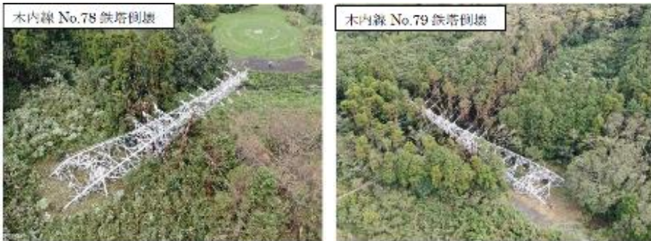
倒壊した鉄塔の様子 (木内線No.78,79)
