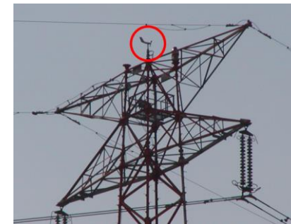
鉄塔頂部に風速計を設置
