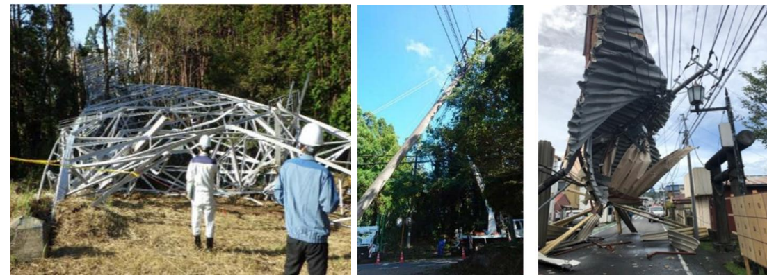
倒壊した鉄塔
