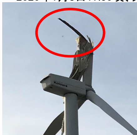
折損した風車の状況
